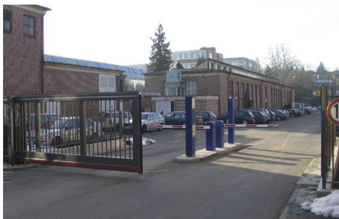
Perfekte Aussenhautsicherung: Freitragendes Schiebetor und Schrankenanlage, videoüberwacht
