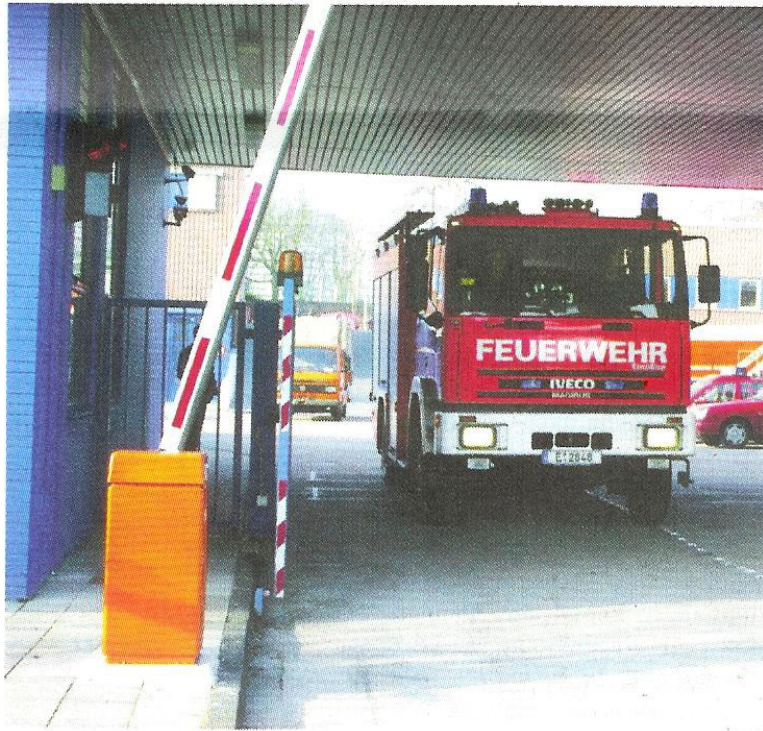
Bei der Essener Feuerwehr wurden zwei komplett neue Schranken zusammen mit dem Trafficscan-System geliefert. Das Video-System – zwei Kameras links oben am Gebäude installiert – erkennt zuverlässig Nummernschilder und öffnet die Schranke für berechnete Fahrzeuge.
